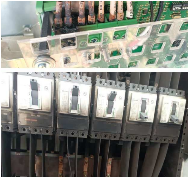
Şekil 8. Supraharmoniklerin Filtrelenmediği Durumda GES İnvertörleri ve GES Panosu Son Durumu
